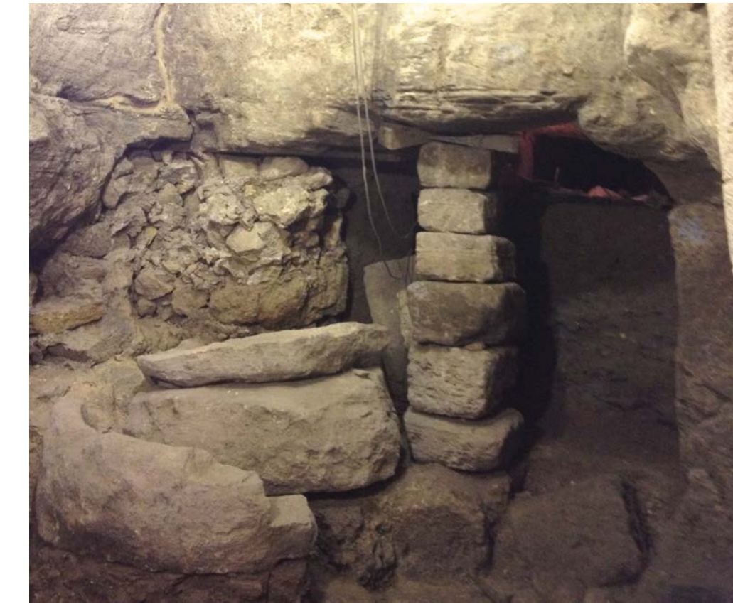
VISTA DEL VANO DI ACCESSO ALL'IPOGEO CON PILASTRO PROVVISORIO IN CONCI DI PIETRA POSATI A SECCO
