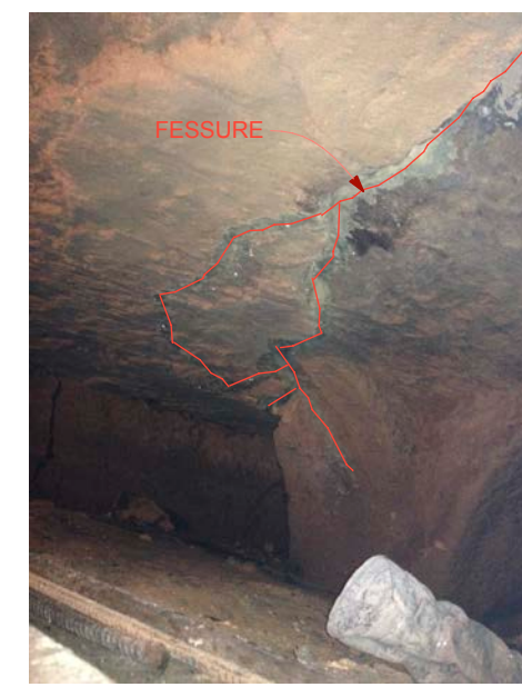
VISTA DA NORD INGRESSO IPOGEO E MASCHIO MURARIO SOVRASTANTE
