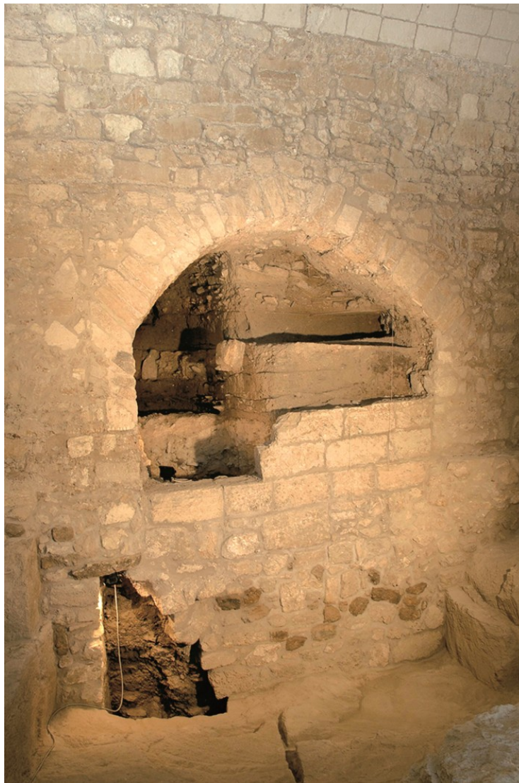
Fig. 3 – Galleria settentrionale 2° arco di scarico
