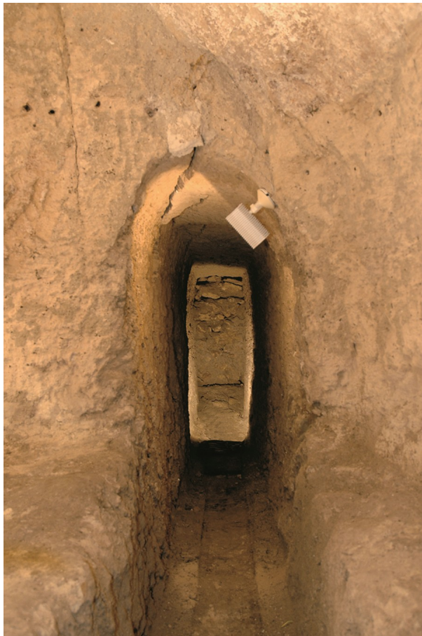
Fig. 7d – Diramazione verso sud del cunicolo scavato nel carparo con finalità difensive
