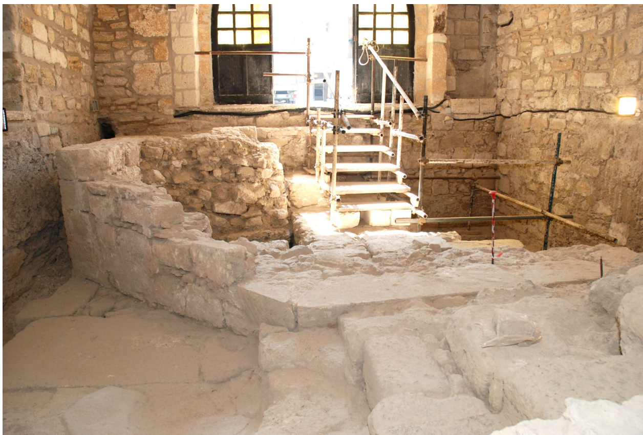
Fig. 16 – Incamiciatura ottagonale sveva costruita intorno alla torre quadrangolare bizantina situata a destra della scala di fortuna
