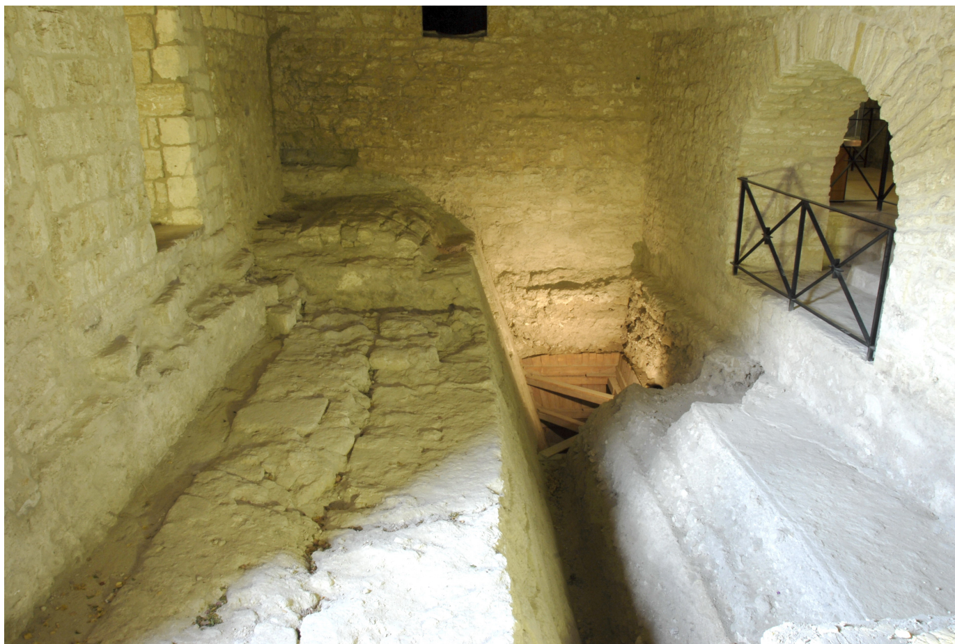
Fig. 16a – Cinta muraria scarpata svevo-angioina situata sotto l'armeria spagnola vicino alla torre ottagonale
