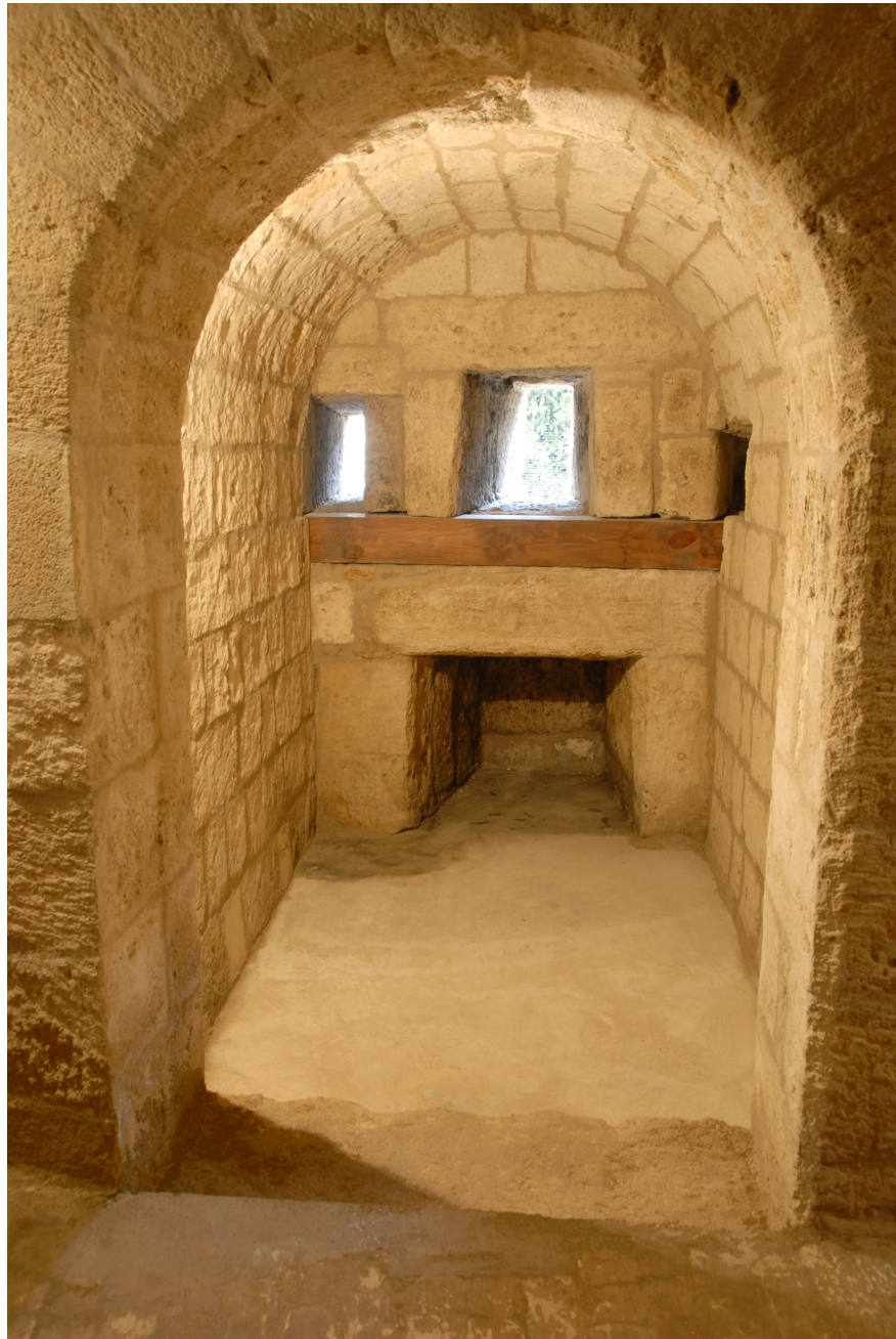
Fig. 27c- Casamatta aragonese che mostra la trave lignea sotto le feritoie per l'inserimento della forcella di supporto dell'archibugio
