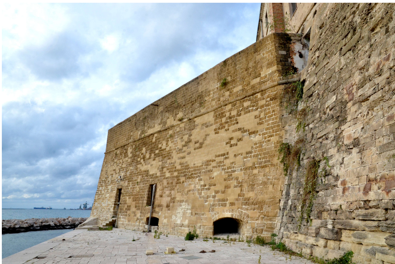
Fig. 37b - Puntone triangolare. Sono visibili le cannoniere, probabilmente francesi, situate quasi a livello del mare relative alla batteria del rivellino
