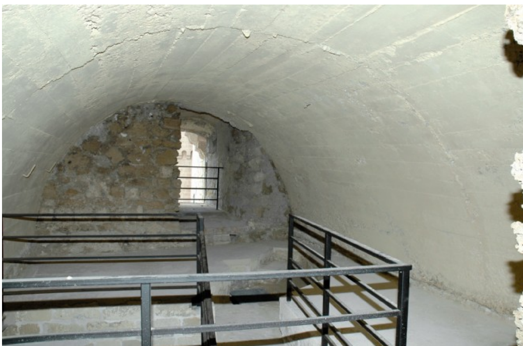
Fig. 43 – Torrione S. Lorenzo – volta in cemento armato
